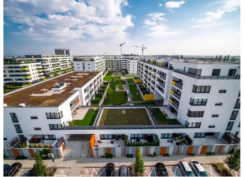
Zelené strechy na obytných budovách v komplexe Arbória.
