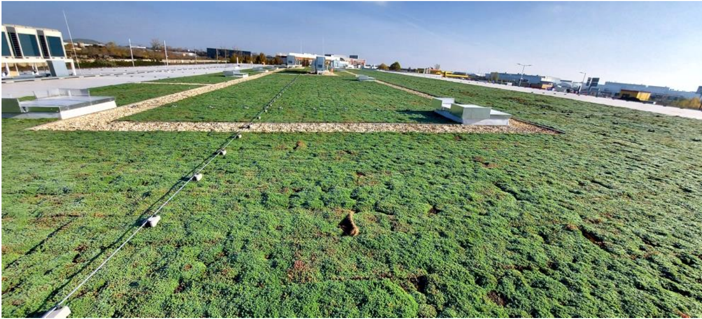
Strecha novej budovy obchodného reťazca na Novej ulici.
