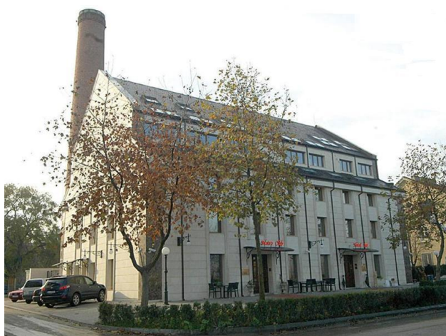
Obr. 13.3 Bývala elektráreň po rekonštrukcii
