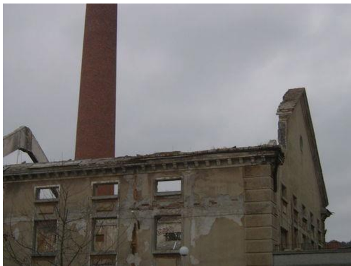
Obr. 13.4 Bývala elektráreň pred rekonštrukciou
